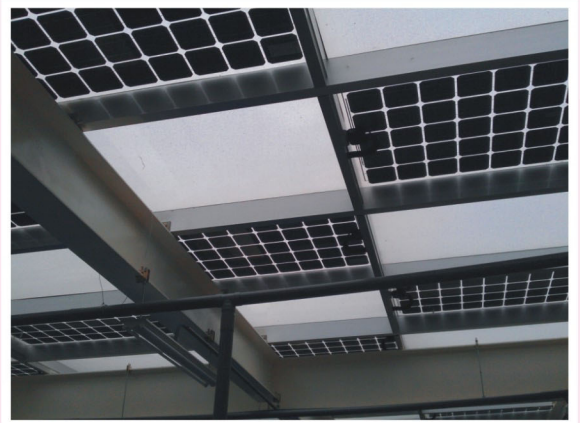
圖1 架設在屏科大水產養殖系實習養殖池上方之BIPV太陽能模組
